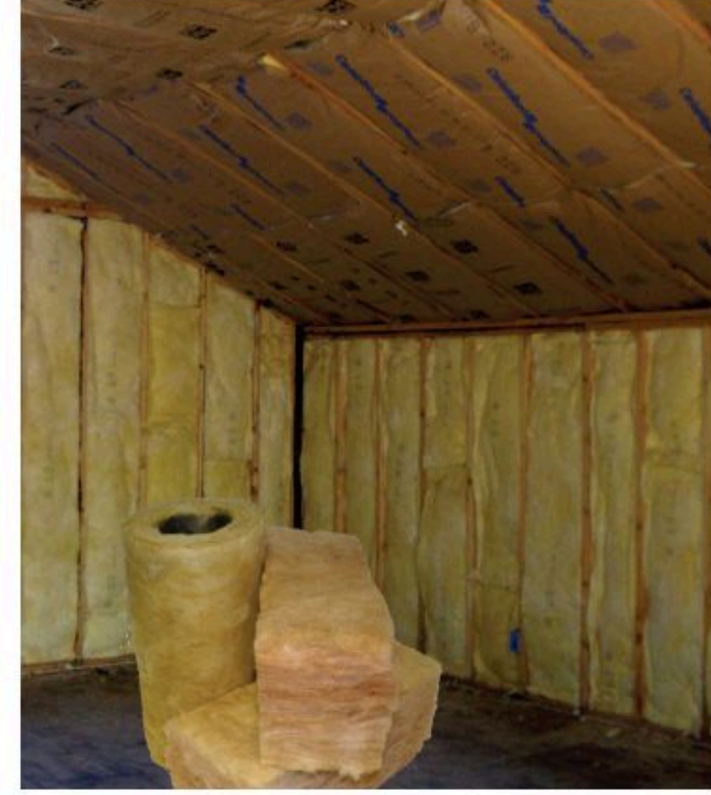
الشكل ٧ تعمل المواد العازلة في المنازل والبنيات على تقليل من انتقال الطاقة الحرارية بين الهواء داخل المنزل والهواء خارجه.
