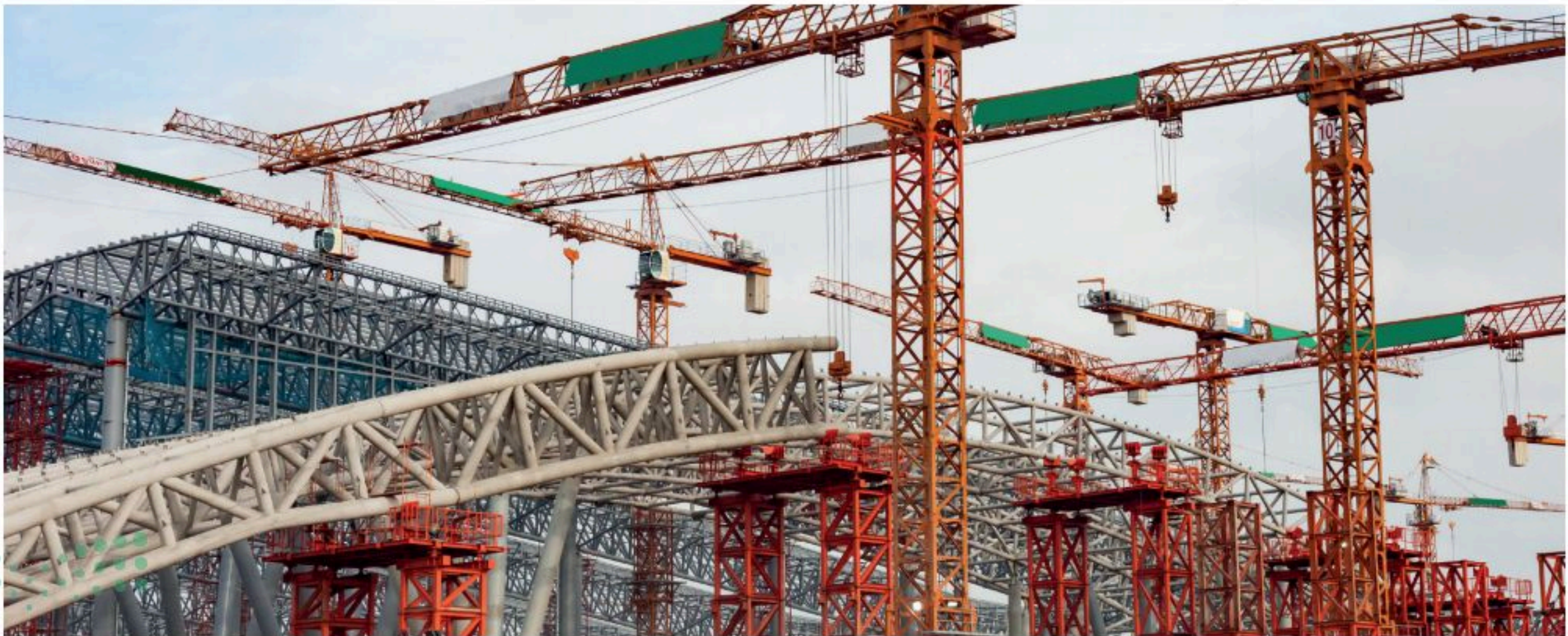
شكل 1.8: إنشاء قطار الأنفاق (المترو) في الرياض
