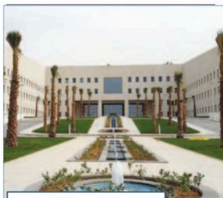
مبنى وزارة التعليم
