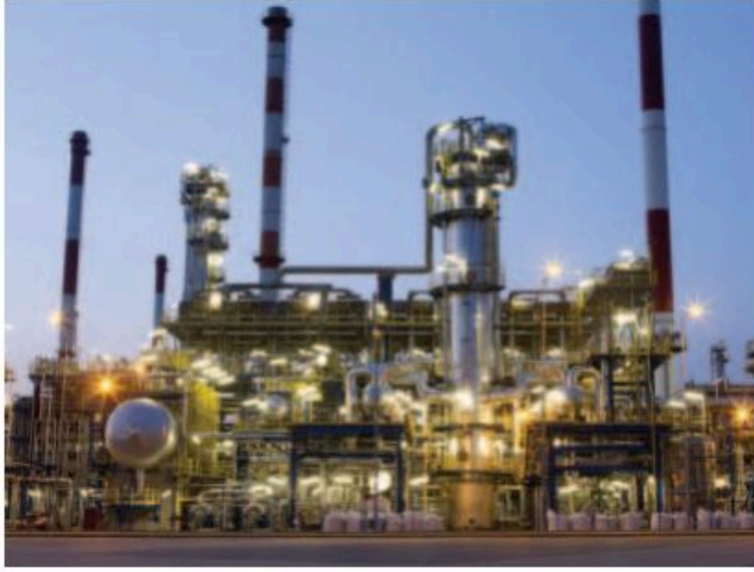
محطة توليد الكهرباء في الجبيل
