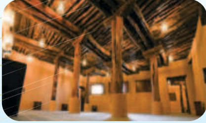
مسجد تاريخي بعد ترميمه
