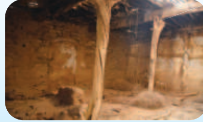
مسجد تاريخي قبل ترميمه
