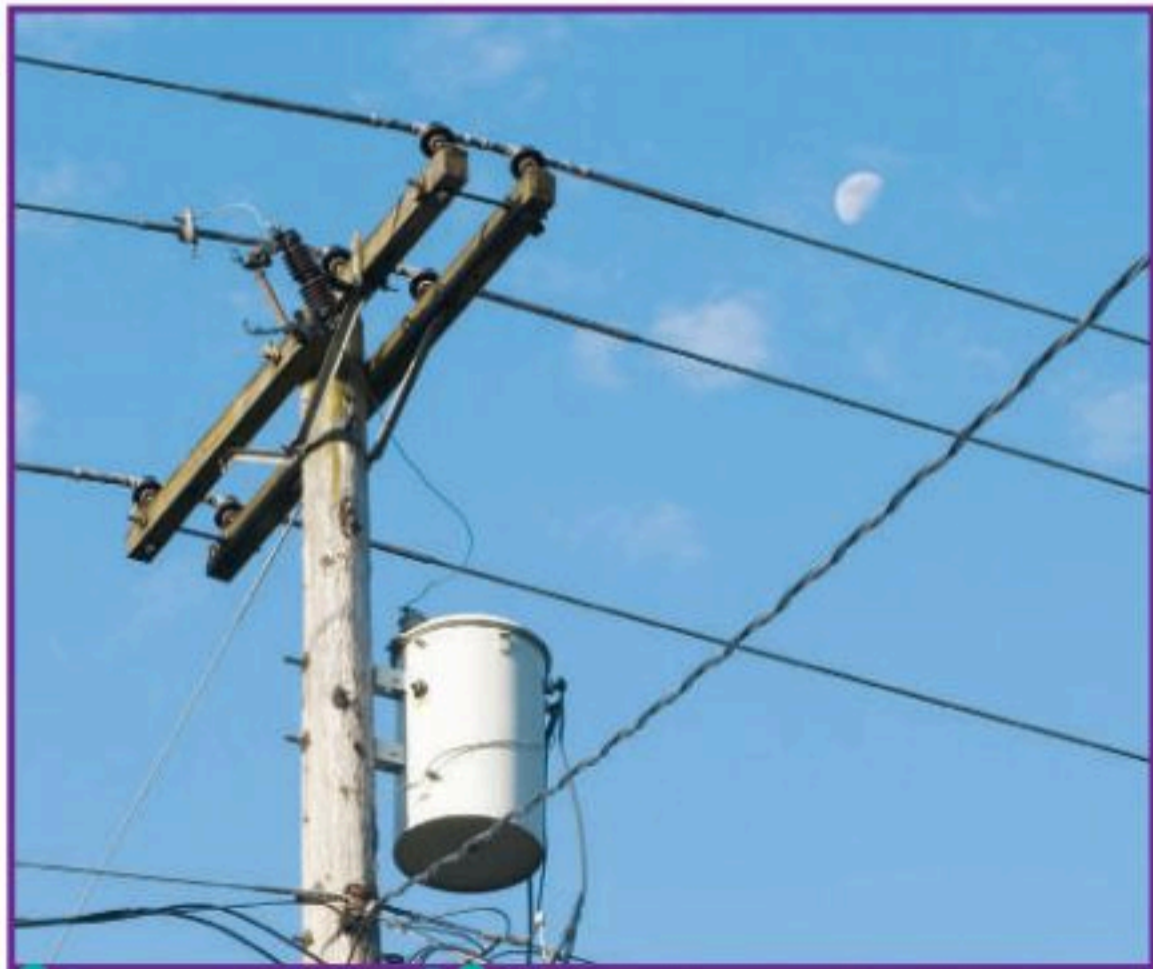
هناك أدوات تُسمّى المحولات تستعمل المغناطيسية لخفض التيار الكهربائي إلى قدرٍ مناسبٍ ليُستخدم في المنازل.
