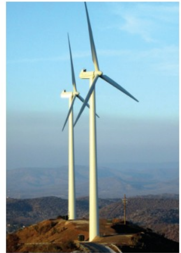
الشكل ٦ تعمل مراوح الهواء بنفس مبدأ منشآت الطاقة، وبدلاً من إدارة المحرك بالبخر يُدار بالمراوح التي تحركها الرياح. صف بعض مزايا وسلبيات استعمال مراوح الهواء.
