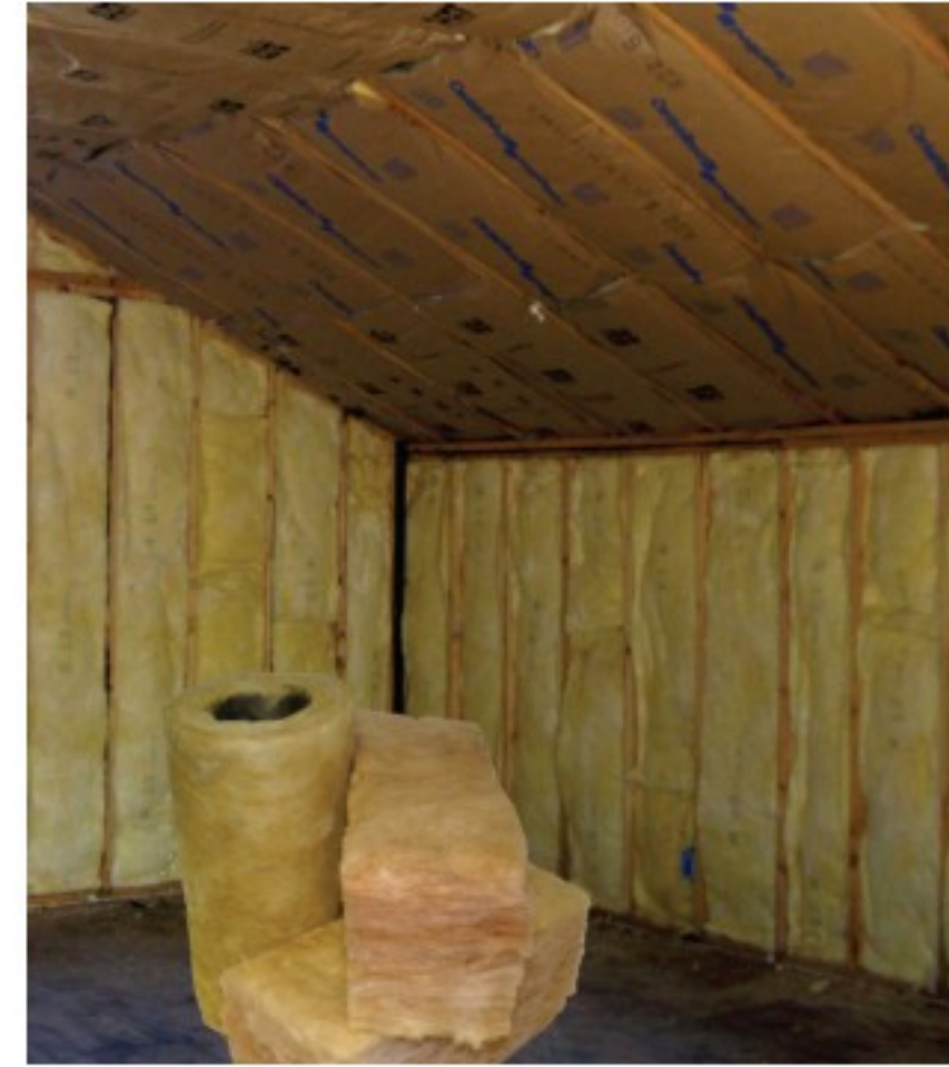
الشكل ٧ تعمل المواد العازلة في المنازل والبنيات على تقليل انتقال الطاقة الحرارية بين الهواء داخل المنزل والهواء خارجه.
