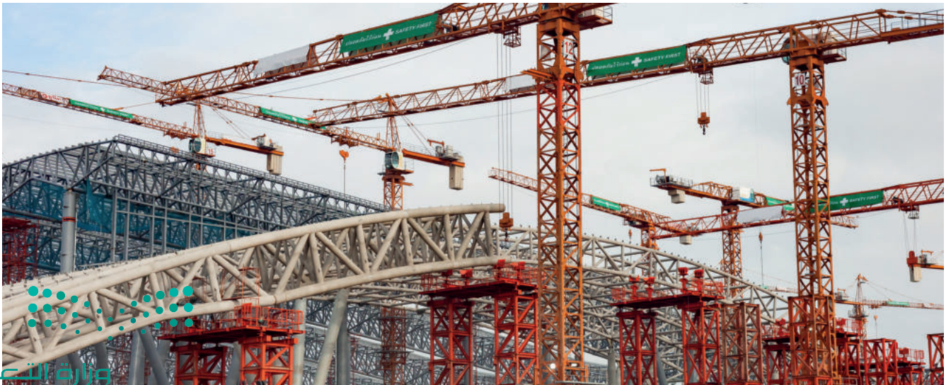
شكل 1.8: إنشاء قطار الأنفاق (المترو) في الرياض
