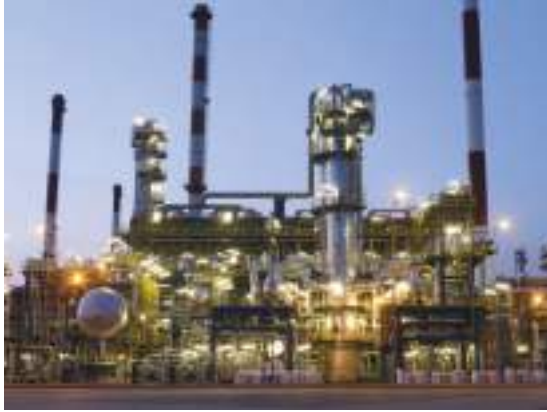
محطة توليد الكهرباء في الجبيل
