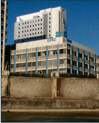
▲ مبنى منظمة أوبك في فيينا
