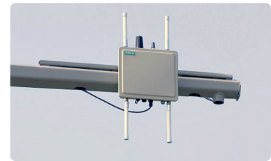
شكل 3.6: وحدة على جانب الطريق (RSU)
