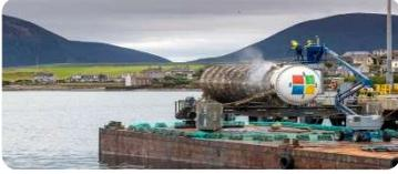
• قامت مايكروسوفت ببناء مركز بيانات تحت الماء باسم مشروع ناتيك حيث يمتاز قاع المحيط بدرجة حرارة مياه ثابتة ولا يتأثر بالعواصف والتيارات المائية.
