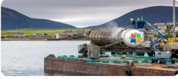
• قامت مايكروسوفت ببناء مركز بيانات تحت الماء باسم مشروع ناتيك حيث يمتاز قاع المحيط بدرجة حرارة مياه ثابتة ولا يتأثر بالعواصف والتيارات المائية.
