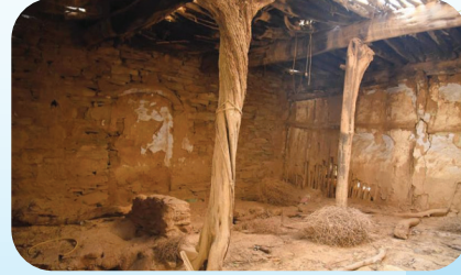
مسجد تاريخي قبل ترميمه
